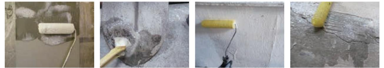
無希釈ウールローラー塗布状況 無希釈刷毛塗布状況 無希釈マスチックローラー塗布状況 添加剤入りマスチックローラー塗布状況
