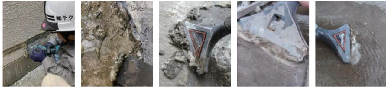
有機塗膜の剥離 下地調整材の剥離 下地調整材+有機塗膜の剥離 モルタルの剥離 Pタイル接着剤の剥離
