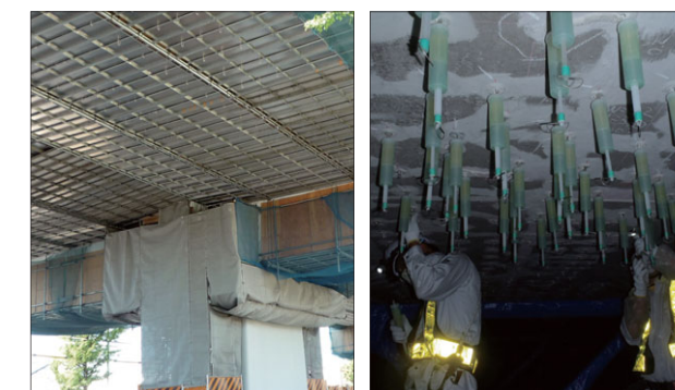
吊り足場全景 IPH施工状況
