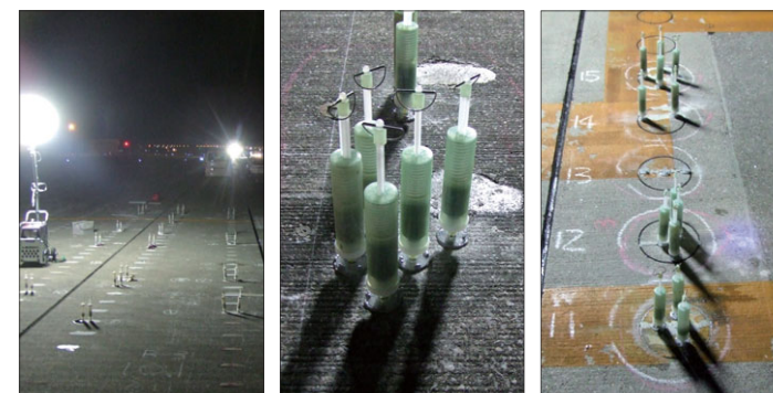
IPH施工全景 IPH施工部位1 IPH施工部位2
