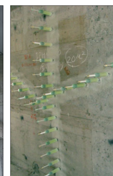
IPH施工中壁
