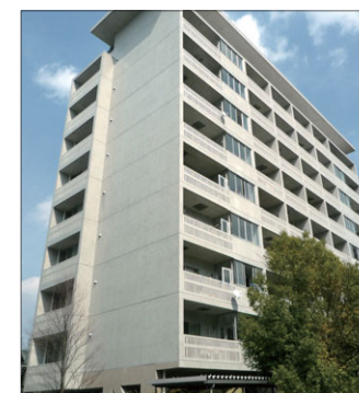
仕上SA-FG工法完了
