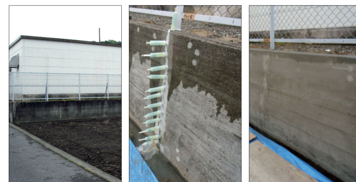
着手前全景 IPH施工 完了
