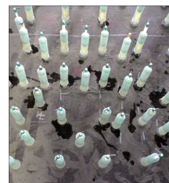
床IPH施工中
