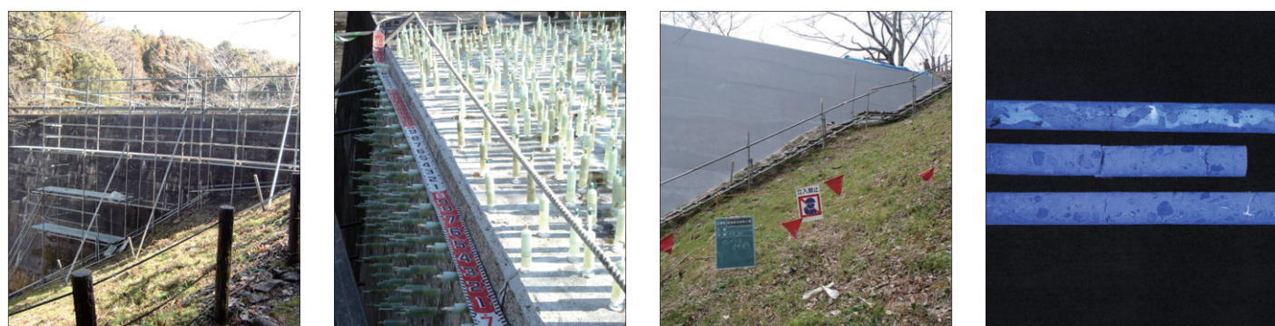
全景・仮設 IPHカプセル 仕上げ完了 樹脂注入コア
