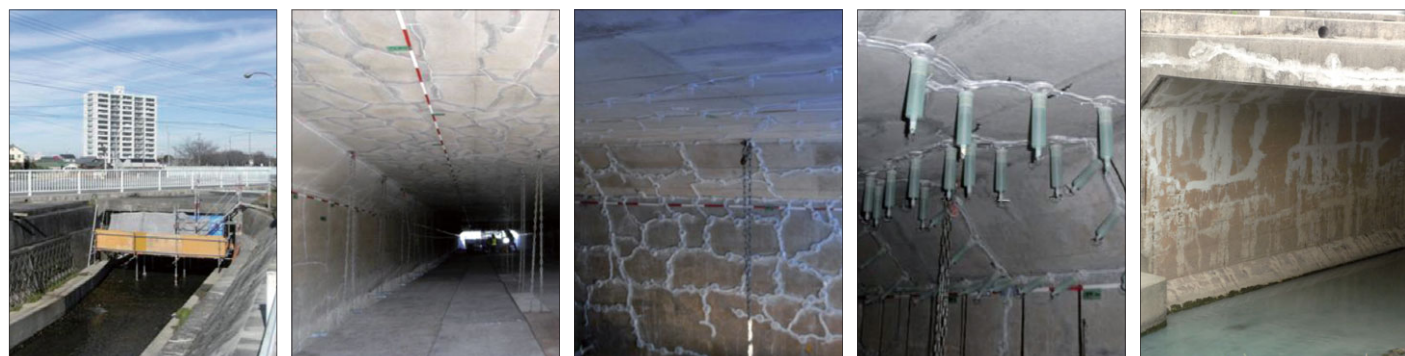
全景下流より VDR・マーキング JP台座・ピックアップシール IPHカプセル 完了下流より
