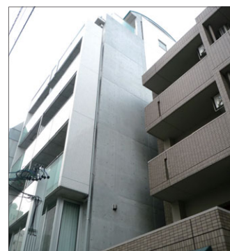
仕上SA工法完了
