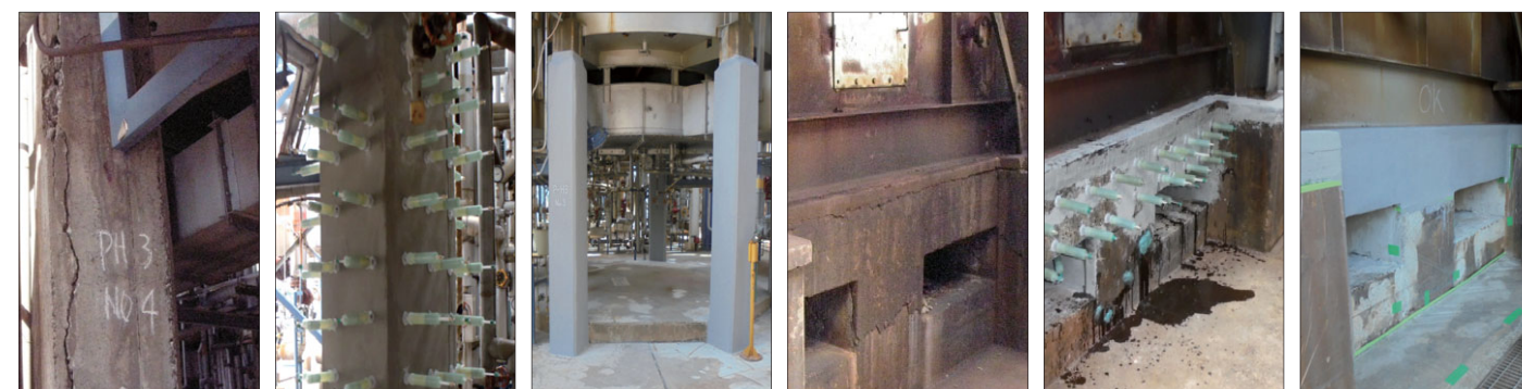
着工前 IPH 完了 着工前 IPH 完了
