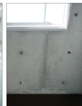
SA工法完了
