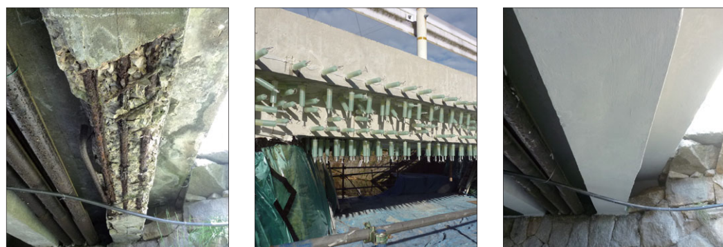
劣化状況 断面修復後IPH 仕上げ完了
