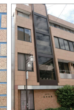
完工・S造部MA砂岩剥落対策仕上げ
